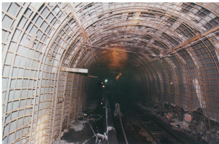
图 43 网壳锚喷工程应用
