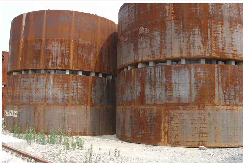
图 22 双层钢板高强混凝土复合井壁现场应用
